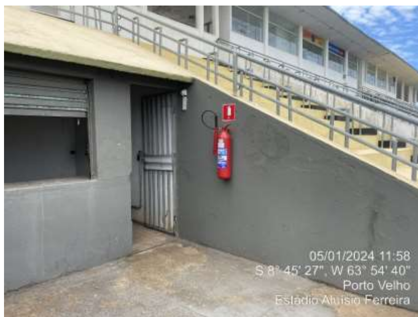
EXTINTORES DE CARGA DE PÓ 20BC E CARGA D'ÁGUA 2A
